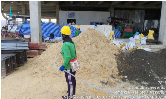
รูปที่ 2-9 การฉีดพรมน้ำกองดินให้เปียกเสมอ
