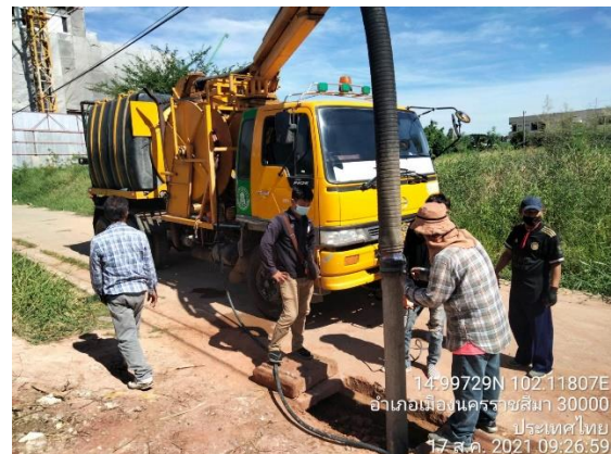
รูปที่ 2-17 เทศบาลฯ ชุดลอกร่องระบายน้ำบริเวณบ้านข้างเคียงโครงการ
