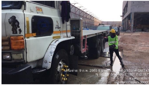
รูปที่ 2-11 การฉีดทำความสะอาดล้อรถบรรทุกก่อนออกจากโครงการ
