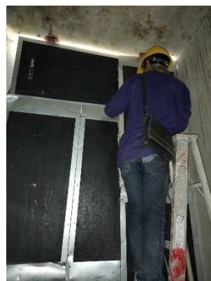
รูปที่ 2-30 แผ่นกันเสียงชนิด Bloxteg 2 Tuff Series
