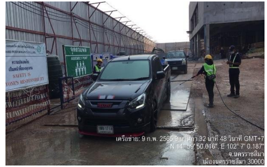
รูปที่ 2-11 การฉีดทำความสะอาดล้อรถบรรทุกก่อนออกจากโครงการ
