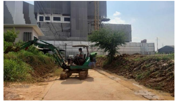
รูปที่ 2-38 การขุดร่องน้ำในซอยบ้านข้างเคียง
