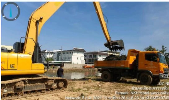
รูปที่ 2-44 ขุดลอกคลองฝั่งซ้ายประตูระบายน้ำคนชุม
