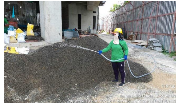
รูปที่ 2-9 การฉีดพรมน้ำกองดินให้เปียกเสมอ
