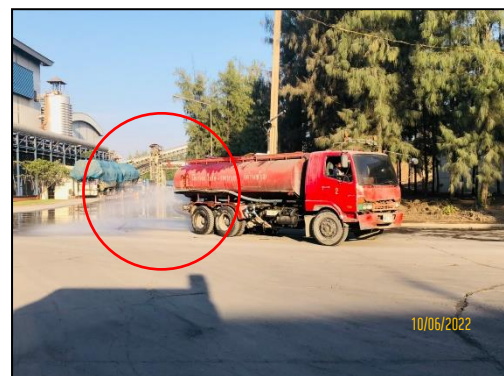
รูปที่ 2-6 ฉีดพรมน้ำในบริเวณเส้นทางเข้า-ออกของพื้นที่โครงการก่อสร้างในตอนบ่ายเพื่อลดการฟุ้งกระจายของฝุ่นละออง
