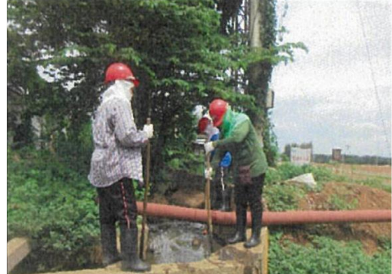
รูปที่ 34 การขุดลอกระบบระบายน้ำ
