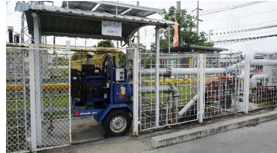
รูปที่ 15 การติดตั้งปั๊มสูบน้ำป้องกันน้ำท่วม
