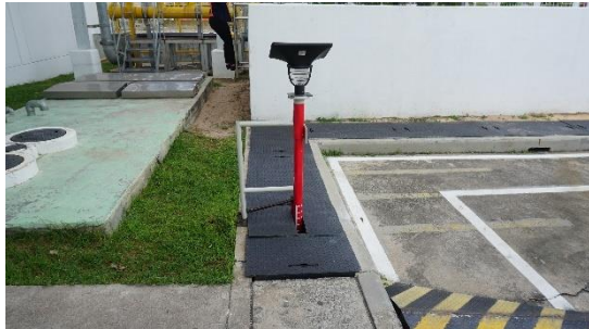
รูปที่ 14 การติดตั้งเสาวัดระดับน้ำในรางระบายน้ำฝน
