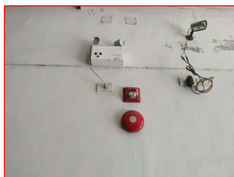
ภาพที่ (7) การติดตั้งสัญญาณเตือนภัย อุปกรณ์ดับเพลิง และไฟฉุกเฉิน
