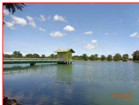
ภาพที่ (5) บ่อน้ำดิบ (Reservoir) ขนาดความจุ 500,000 ลบ.ม.
