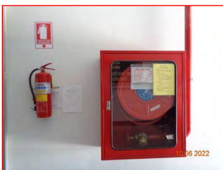
ภาพที่ (7) การติดตั้งสัญญาณเตือนภัย อุปกรณ์ดับเพลิง และไฟฉุกเฉิน
