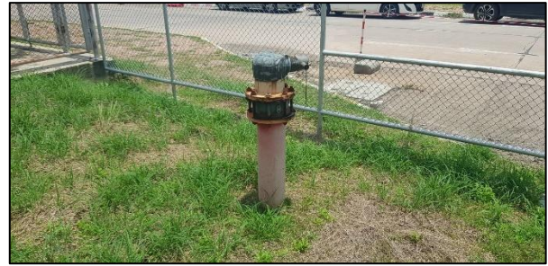
รูปที่ 2.2-27 หัวรับน้ำดับเพลิงจากภายนอกที่ชั้น 1
