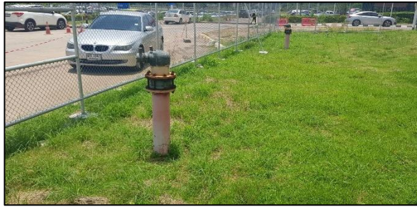
รูปที่ 2.2-27 หัวรับน้ำดับเพลิงจากภายนอกที่ชั้น 1
