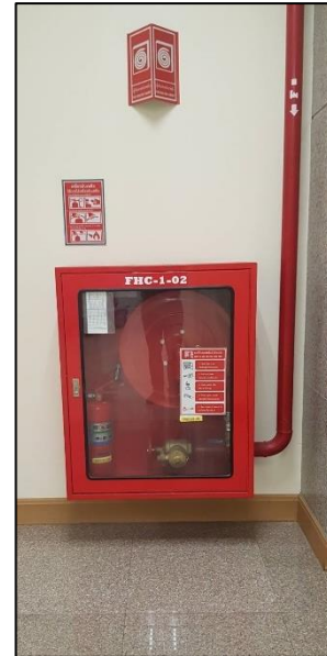
รูปที่ 2.2-24 อุปกรณ์ดับเพลิง สายส่งน้ำ (Fire Hose) ยาว 30 เมตร ภายในโครงการ
