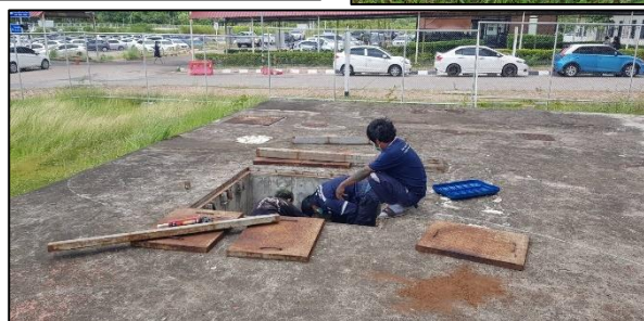
รูปที่ 2.2-17 บ่อดักไขมันหลังอาคารโรงอาหารและการทำความสะอาดบ่อดักไขมัน
