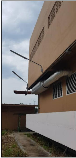
รูปที่ 2.2-13 ประตुरะบายอากาศ และพัดลมดูดอากาศภายในห้องเครื่องกำเนิดไฟฟ้า
