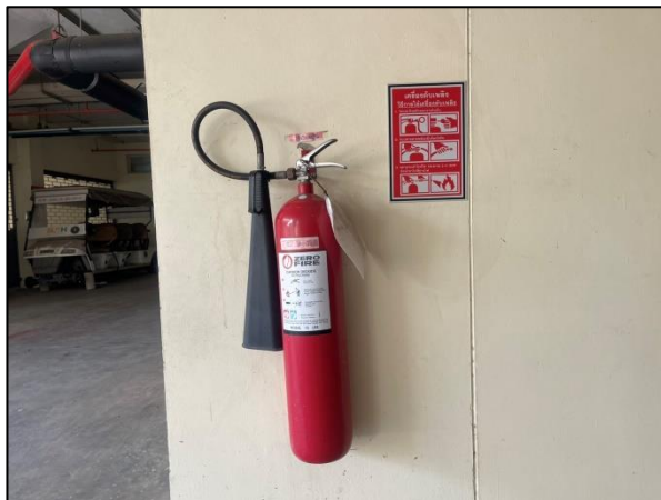
รูปที่ 2.2-25 ถังดับเพลิงเคมีชนิดมือถือ
