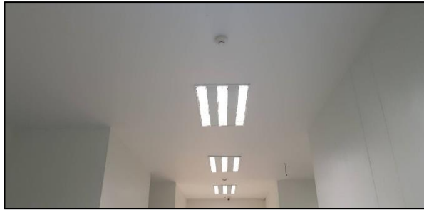
รูปที่ 2.2-23 เครื่องตรวจจับควัน (Smoke Detector) ภายในโครงการ
