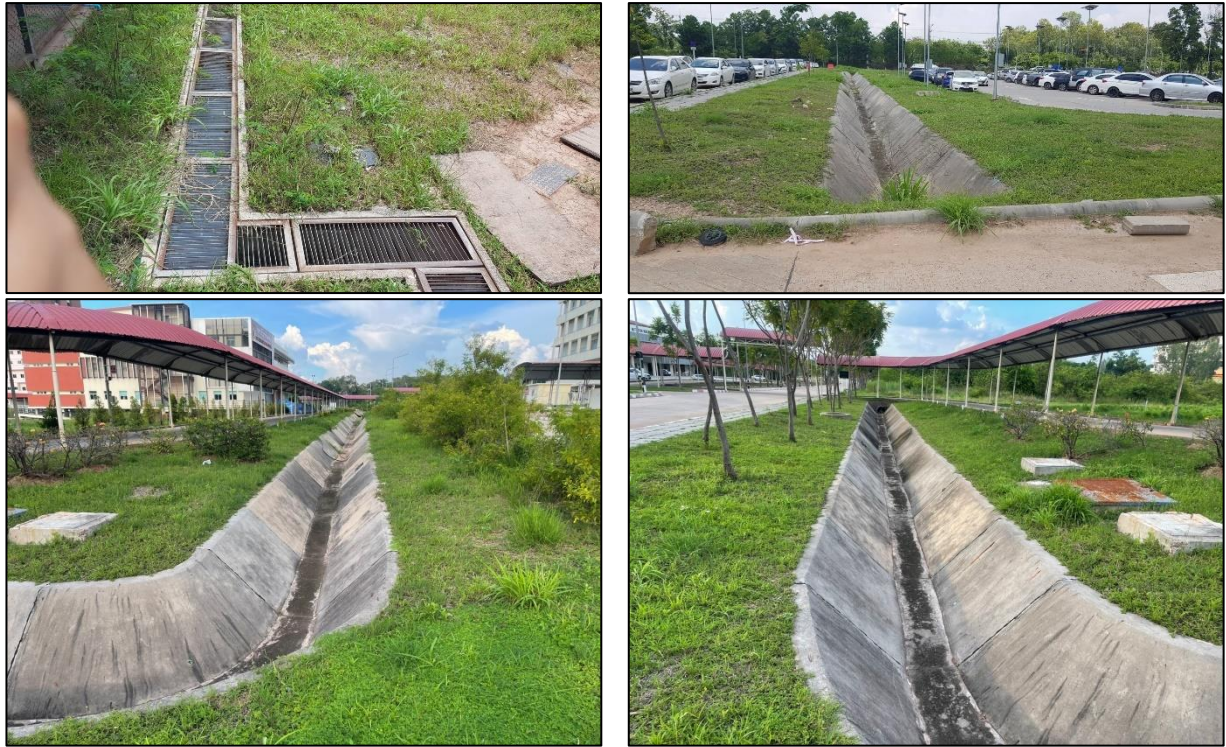
รูปที่ 2.2-18 รางระบายน้ำฝนของโครงการ
