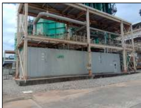
รูปที่ 2-4 การติดตั้งอุปกรณ์ลดเสียงดังจากเครื่องจักร
