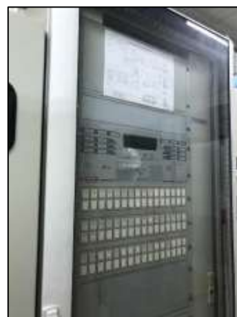
รูปที่ 2-22 อุปกรณ์ตรวจวัดก๊าซไวไฟ (Flammable Gas Detector) และอุปกรณ์ตรวจวัดความปลอดภัยอื่นๆ และ เชื่อมต่อกับสัญญาณฉุกเฉิน ซึ่งควบคุมได้จากศูนย์ควบคุมกลาง (Central Control Panel)
