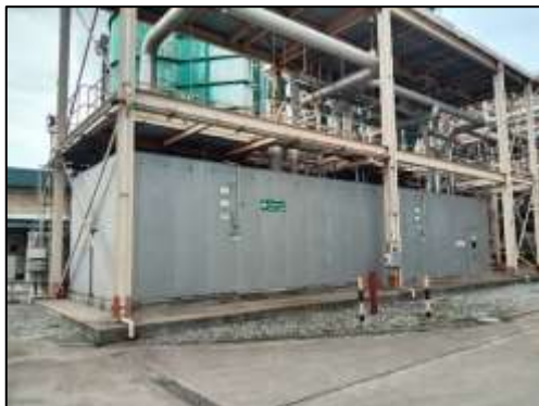
รูปที่ 2-17 ระบบฉนวนป้องกันความร้อน หรือฉากป้องกันความร้อน
