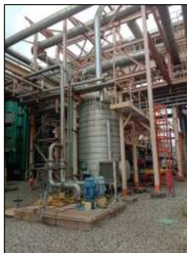
รูปที่ 2-17 ระบบฉนวนป้องกันความร้อน หรือฉากป้องกันความร้อน
