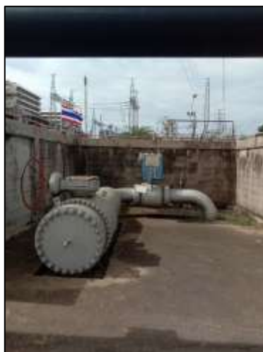
รูปที่ 2-26 ระบบควบคุมการ Shutdown ท่อส่งก๊าซธรรมชาติ
