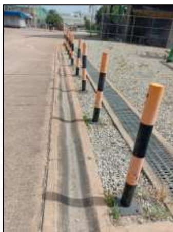
รูปที่ 2-10 รางระบายน้ำฝนโดยแยกน้ำฝนปนเปื้อนและน้ำฝนไม่ปนเปื้อนออกจากกัน
