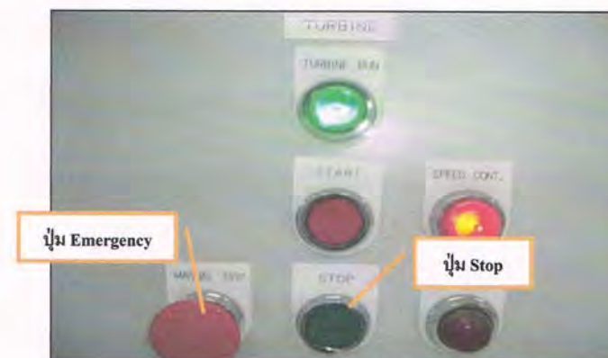
รูปที่ 1 ปุ่ม STOP เครื่องกังหันไอน้ำ
