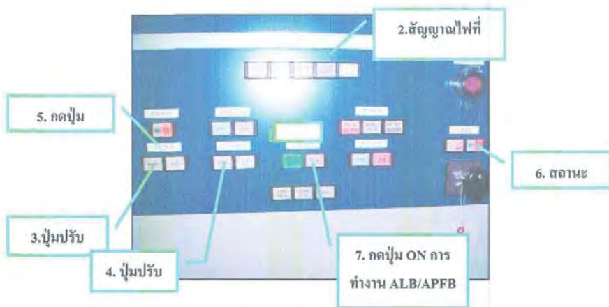
รูปที่ 4 ขั้นตอนการ ON เครื่องกำเนิดไฟฟ้า GCP1
