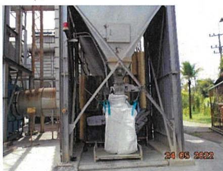
ภาพที่ 2-3 ระบบดักฝุ่นแบบถุงกรอง
