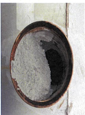
Fig.2 เมื่อทำการเปิดดูแล้ว พบว่ามีหินที่ตกค้างในท่อ ประมาณ 50 % ของท่อ
