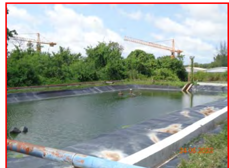
ภาพที่ 2.2-10 บ่อพักน้ำฉุกเฉิน (กรณีระบบบำบัดน้ำเสียขัดข้อง)
