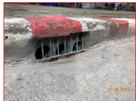
ภาพที่ 2.2-12 รางระบายน้ำฝนทั่วไป
