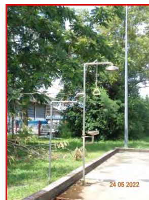
ภาพที่ 2.2-33 จุดชำระล้างร่างกายและล้างตาฉุกเฉิน (บริเวณที่มีการขนส่งหรือกักเก็บสารเคมี)
