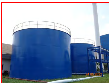
ภาพที่ 2.2-37 ถังสำรองน้ำใช้และน้ำดับเพลิง
