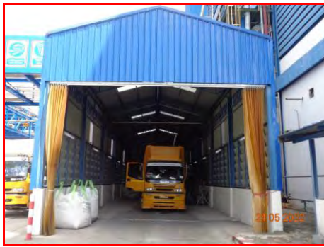
ภาพที่ 2.2-1 ระบบควบคุมฝุ่นระหว่างการขนถ่าย PTA
