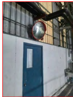
ภาพที่ 2.2-44 การติดตั้งกระจกโค้ง (Traffic Mirror)
