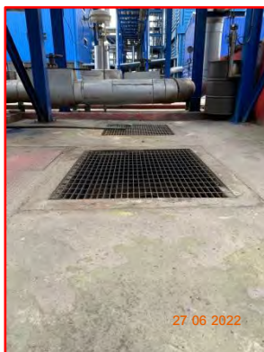
ภาพที่ 2.2-13 รางระบายน้ำฝนปนเปื้อน
