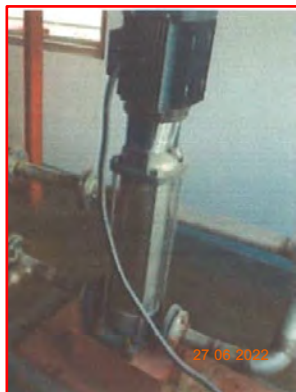
เครื่องสูบน้ำแรงดัน (Jockey Pump)
