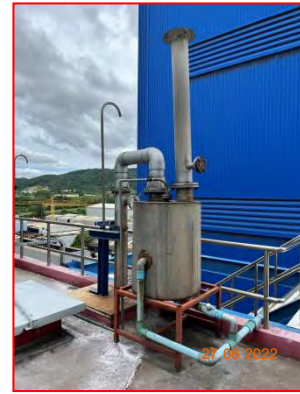
ภาพที่ 2.2-2 ระบบ Scrubber ที่ป้องกัน Catalyst Feed Vessel
