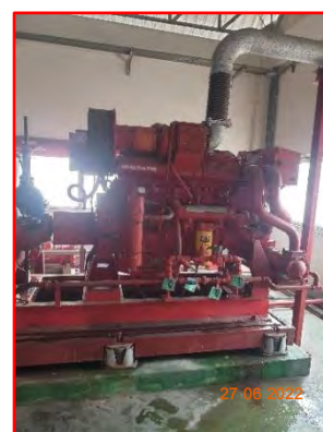
เครื่องสูบน้ำดับเพลิงแบบเครื่องยนต์ดีเซล
