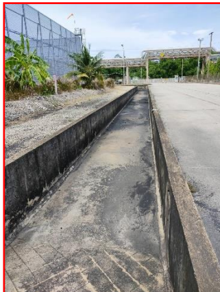
ภาพที่ 2.2-17 ร่องน้ำขนาดกว้าง 2 เมตร ลึก 1.5-2.2 เมตร ล้อมรอบกองถ่านหิน
