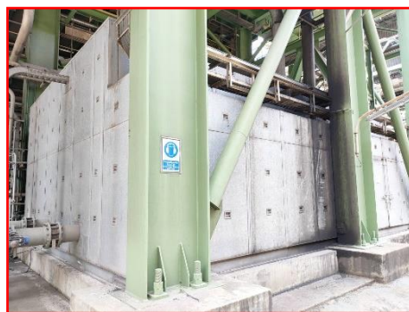
ภาพที่ 2.2-38 อุปกรณ์ลดเสียง Silencer และปิดครอบเครื่องจักรที่มีเสียงดัง
