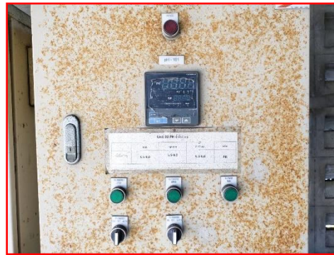
ภาพที่ 2.2-16 pH Meter แบบอัตโนมัติ บริเวณบ่อปรับสภาพกรด-ด่าง
