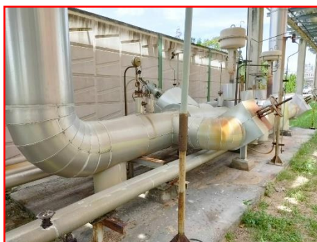
ภาพที่ 2.2-39 ระบบฉนวนป้องกันความร้อน และการปิดคลุมที่แหล่งกำเนิดความร้อน
