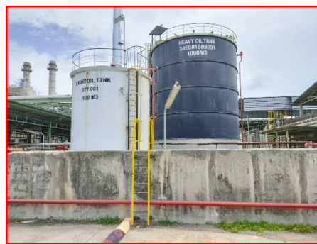
ภาพที่ 2.2-13 Dike สำหรับกั้นเก็บสารเคมีและถังสำรองเชื้อเพลิง
