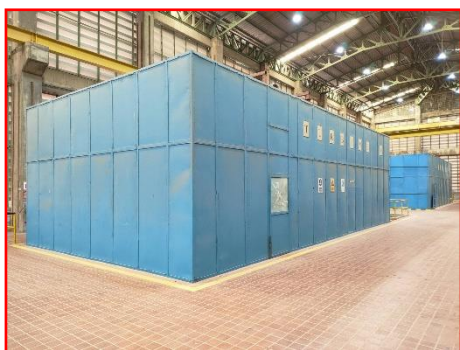
ภาพที่ 2.2-38 อุปกรณ์ลดเสียง Silencer และปิดครอบเครื่องจักรที่มีเสียงดัง
