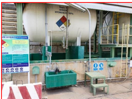
ภาพที่ 2.2-13 Dike สำหรับกั้นเก็บสารเคมีและถังสำรองเชื้อเพลิง
