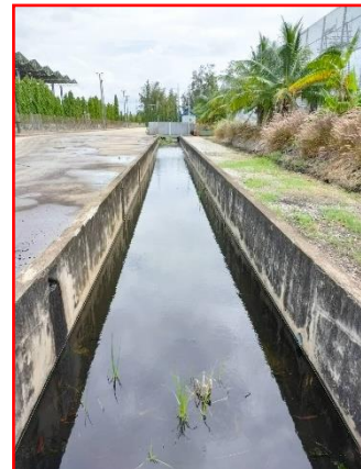
ภาพที่ 2.2-17 ร่องน้ำขนาดกว้าง 2 เมตร ลึก 1.5-2.2 เมตร ล้อมรอบกองถ่านหิน
