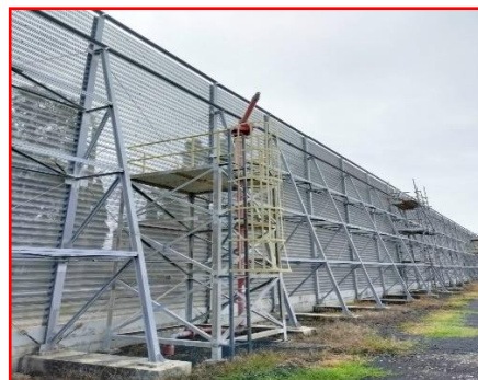
ภาพที่ 2.2-4 การฉีดพรมน้ำบริเวณพื้นที่กองเก็บ เชื้อเพลิงถ่านหิน
