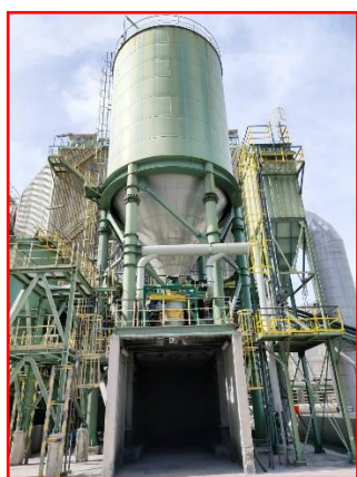
ภาพที่ 2.2-29 ซิโหลเก็บถ้ำเบาแบบปิด
