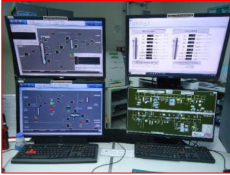
ภาพที่ 2.2-29 ระบบ Distributed Control System (DCS)
