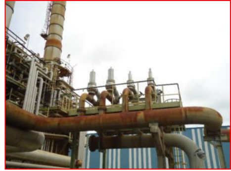
ภาพที่ 2.2-30 ระบบ Double Safety Relief Valve
