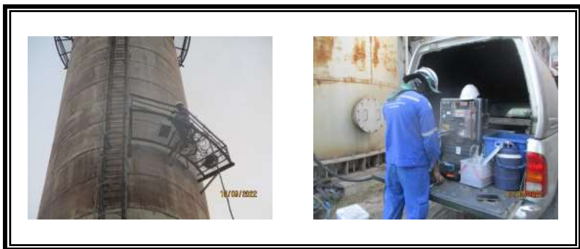
รูปที่ 3.3-2 จุดตรวจวัดคุณภาพอากาศจากปล่องปล่อยทิ้งอากาศเสีย บริเวณหม้อไอน้ำ ชุดที่ 2 ในวันที่ 10 มีนาคม พ.ศ. 2565
