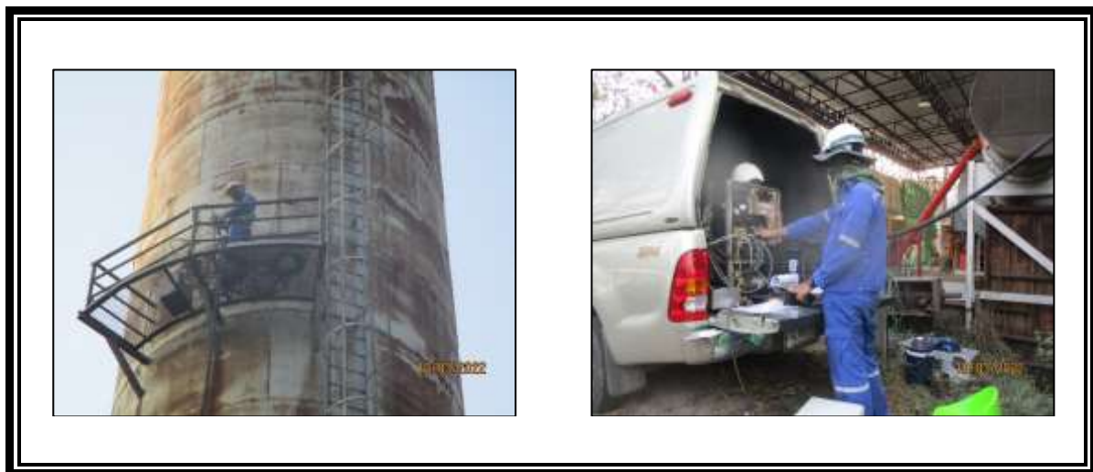
รูปที่ 3.3-1 จุดตรวจวัดคุณภาพอากาศจากปล่องปล่อยทิ้งอากาศเสีย บริเวณหม้อไอน้ำ ชุดที่ 1 ในวันที่ 10 มีนาคม พ.ศ. 2565
