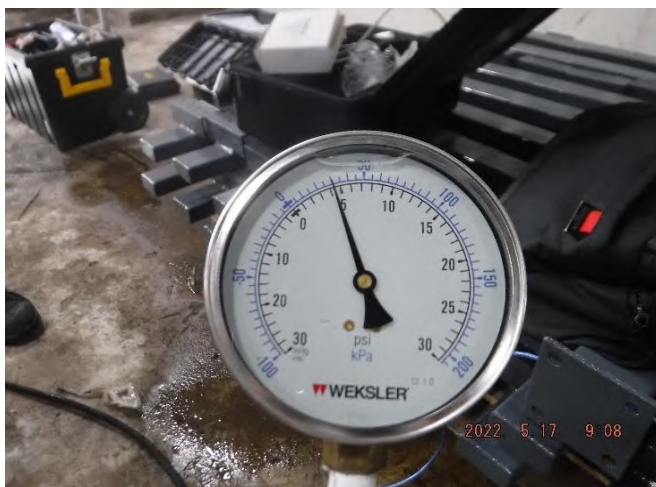
รูปที่ 3 Suction Pressure ที่อ่านค่าได้เท่ากับ 4.4 psi.
