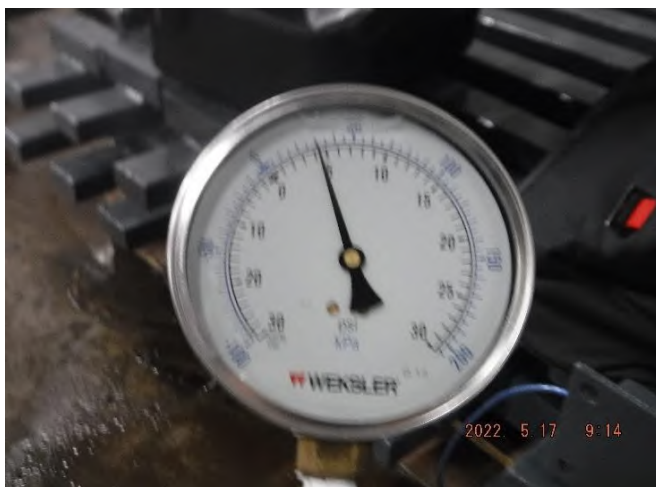
รูปที่ 7 Suction Pressure ที่อ่านค่าได้เท่ากับ 4.4 psi.
