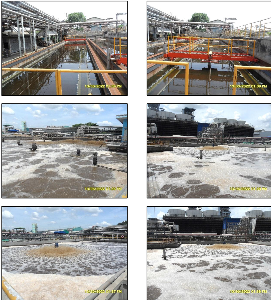
ภาพที่ 2.1 ระบบบำบัดน้ำเสียแบบ Activated Sludge
