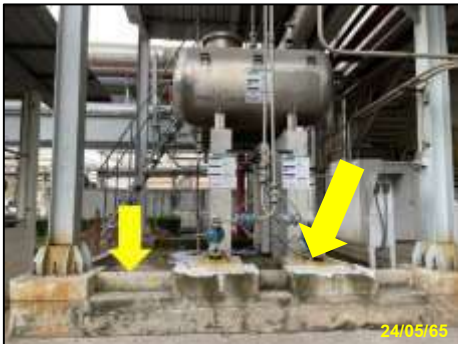
รูปที่ 2-39 เขื่อนป้องกันการรั่วไหลรอบถังบรรจุน้ำมัน
