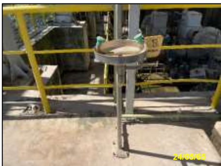
รูปที่ 2-41 อ่างล้างตาและฝักบัวชำระร่างกาย
