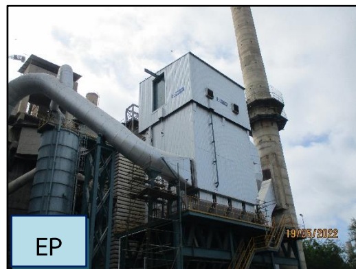
ภาพที่ 2.8 ระบบดักฝุ่น แบบ Electrostatic Precipitator (EP) และ Bag Filter (BF)
