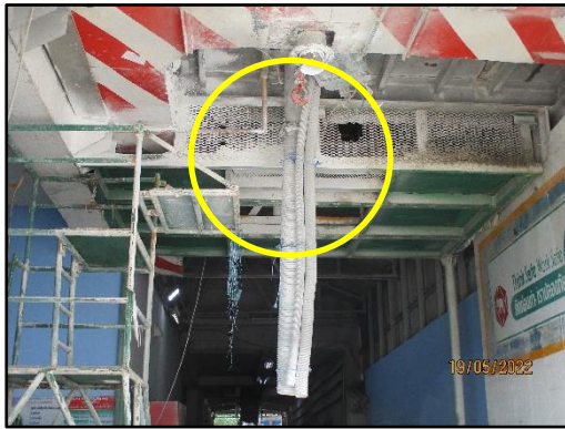
ภาพที่ 2.11 ท่อลมดูดฝุ่นขณะจ่ายปูนซีเมนต์ใส่รถเต๋า
