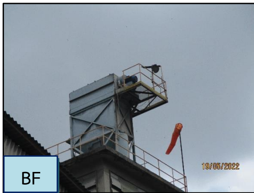
ภาพที่ 2.8 (ต่อ) ระบบดักฝุ่น แบบ Electrostatic Precipitator (EP) และ Bag Filter (BF)
