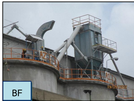
ภาพที่ 2.8 (ต่อ) ระบบดักฝุ่น แบบ Electrostatic Precipitator (EP) และ Bag Filter (BF)
