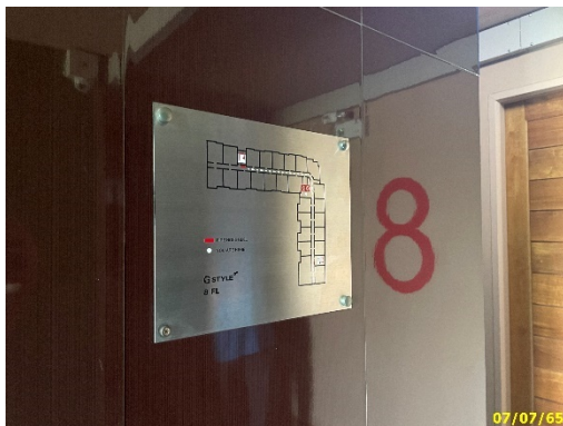
แผนผังเส้นทางหนีไฟและป้ายบอกเลขชั้น
