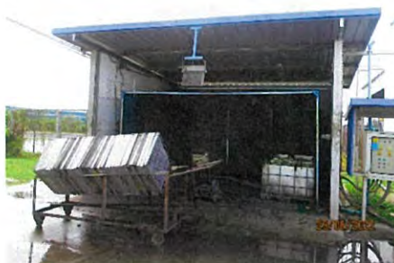
ภาพที่ 2.2-17 จุดชักล้าง โดยนำน้ำที่ผ่านการบำบัดแล้ว กลับมาใช้ล้างวัสดุ อุปกรณ์ต่างๆ
