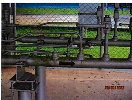
ภาพที่ 2.2-55 ข้อความแสดงทิศทางการหมุนวาล์วและ ข้อความแสดงทิศทางการไหลในท่อขนส่งก๊าซธรรมชาติ
