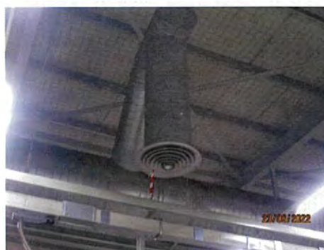
ภาพที่ 2.2-42 ระบบทำความเย็น เพื่อควบคุมอุณหภูมิในบริเวณพื้นที่ทำงาน
