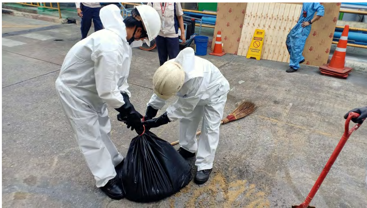
ทีมเก็บกู้สารเคมีหกรั่วไหล ใช้พลั่วตักทรายที่ดูดซับสารเคมีใส่ในภาชนะปิดมิดชิด (ถุงดำมัดปากถุงด้วยเชือกสีแดงให้มิดชิด)
