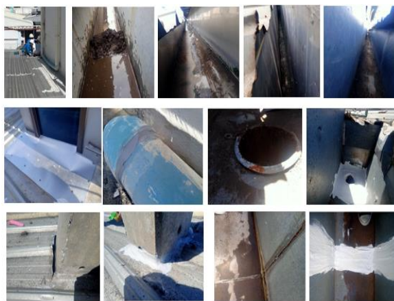
ภาพที่ 2-17 การทำความสะอาดและลอกตะกอน ในรางหรือท่อระบายน้ำฝน
