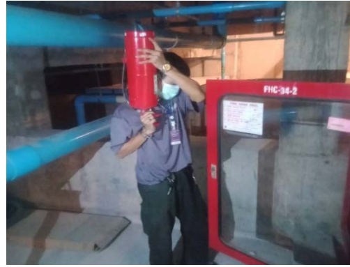
การตรวจสอบอุปกรณ์ในระบบป้องกันและเตือนอัคคีภัย
