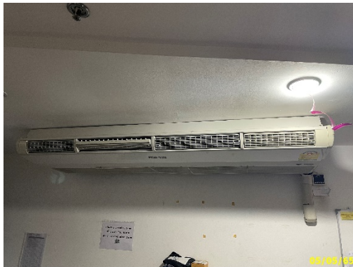
เครื่องปรับอากาศแบบแยกส่วนและการตั้งอุณหภูมิเครื่องปรับอากาศ 25°C
