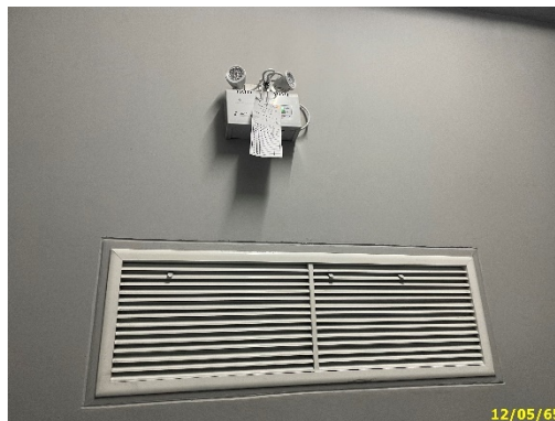
ระบบอัดอากาศภายในโรงลิฟต์ดับเพลิง
