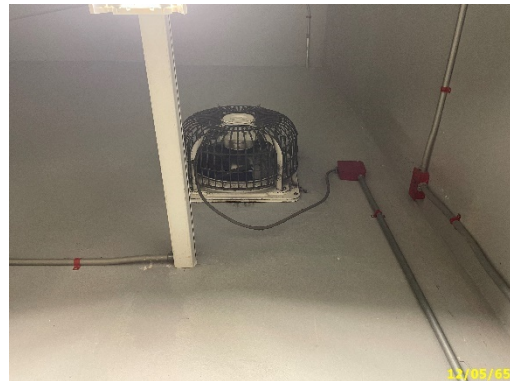
การระบายอากาศโดยใช้พัดลมดูดอากาศ
