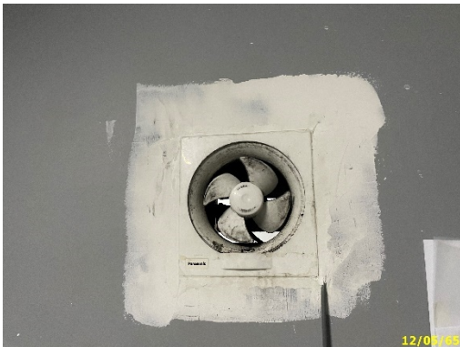
การระบายอากาศโดยใช้พัดลมดูดอากาศ
