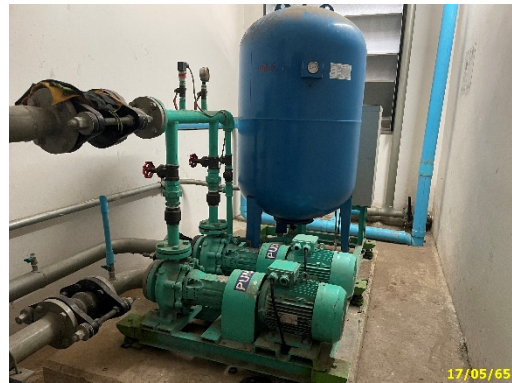
Booster Pump ห้องเครื่องลิฟต์
