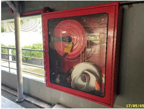
ท่อเย็น และตู้เก็บสายฉีดน้ำดับเพลิงพร้อม อุปกรณ์
