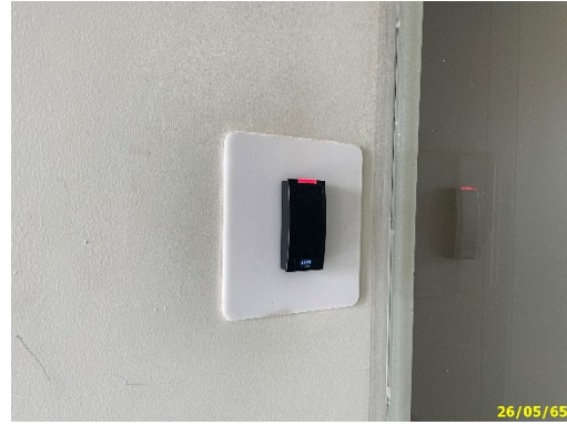
ระบบการควบคุมประตูอัตโนมัติ (Access Control)
