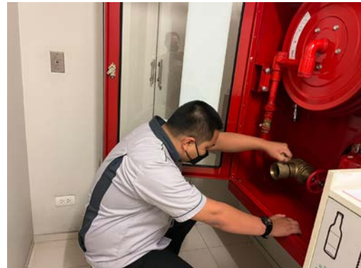
ตรวจสอบตู้ดับเพลิงพร้อมอุปกรณ์
