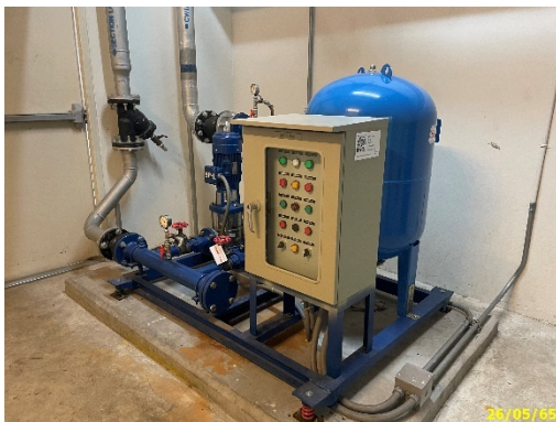
ปั๊มและถังเก็บน้ำสำรองชั้นดาดฟ้า
