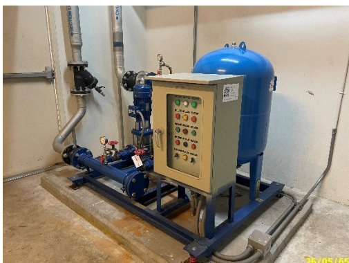
บ่ยมและถังเก็บน้ำสำรองชั้นดาดฟ้า
