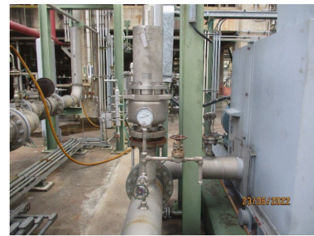
ภาพที่ 2-28 Safety Relief Valve
