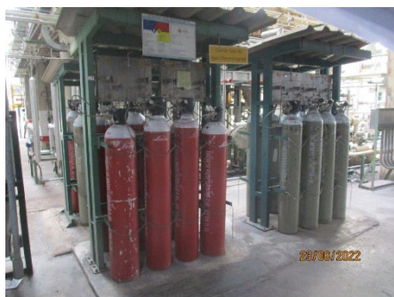
ภาพที่ 2-5 ถังก๊าซ CO เพื่อใช้ในระบบ CO Injection
