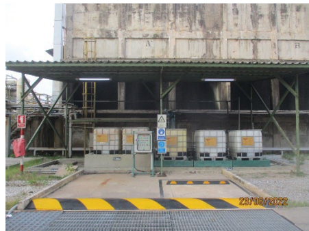
ภาพที่ 2-11 ถัง H_2SO_4 สำหรับปรับ pH ที่ API Separator
