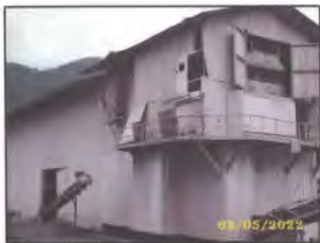
การปิดคลุมโรงโม่หินเป็นระบบปิดทั้ง 3 ด้าน
