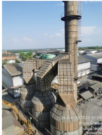
รูปที่ 1 ระบบดักฝุ่นละออง (Wet Scrubber)
