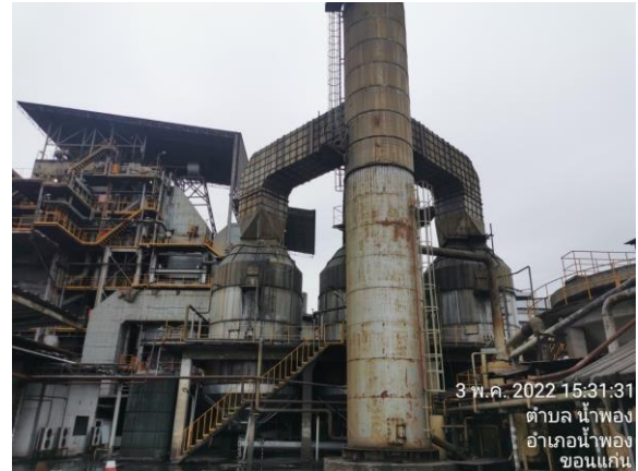
รูปที่ 1 ระบบดักฝุ่นละออง (Wet Scrubber)
