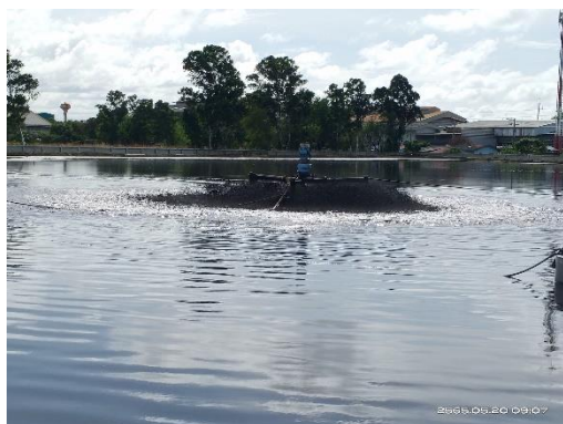
รูปที่ 3 เครื่องเติมอากาศ
