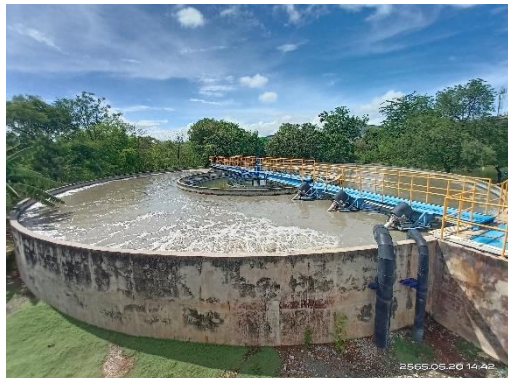
ระบบบำบัดน้ำเสียแห่งที่ 3 ชนิด Extended Activated Sludge
