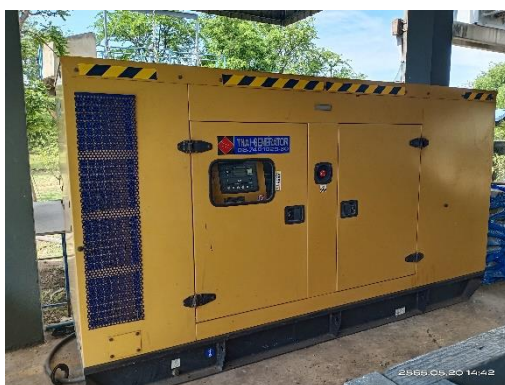
รูปที่ 9 ระบบไฟฟ้าสำรองของระบบบำบัดน้ำเสียส่วนกลางของนิคมฯ
