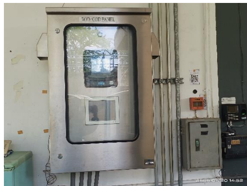
รูปที่ 10 เครื่องตรวจวัดคุณภาพน้ำอัตโนมัติ
