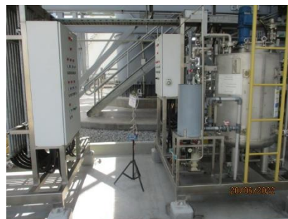
ABPR3_Chemical dosing (HRSG R.3)
