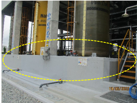
ภาพที่ 2.2-35 คั่นคอนกรีตรอบถังเก็บสารเคมี
