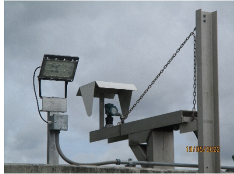
ภาพที่ 2.2-13 ระบบติดตามตรวจสอบคุณภาพน้ำแบบต่อเนื่อง
