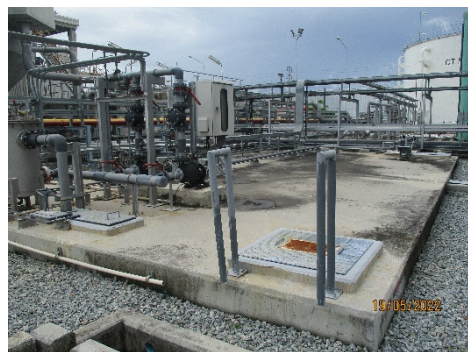
ภาพที่ 2.2-15 บ่อปรับสภาพความเป็นกรด-ด่าง (Neutralization Pit)
