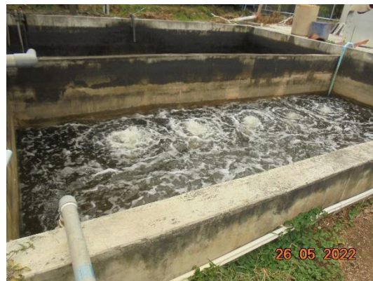
รูปที่ 20 ระบบบำบัดน้ำเสียแบบเคมี
