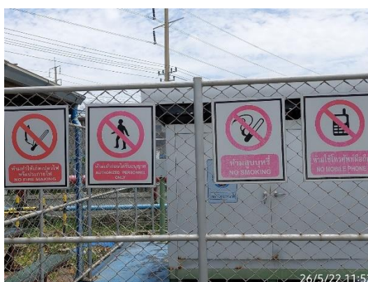
รูปที่ 61 ป้ายสัญลักษณ์เตือนอันตรายจุดเชื่อมต่อและส่งจ่ายก๊าซ NG
