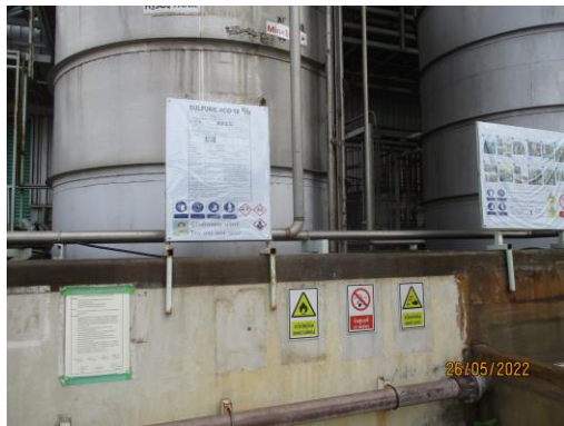
รูปที่ 26 พื้นที่กักเก็บสารเคมีและอุปกรณ์ป้องกันเหตุฉุกเฉิน เช่น ฝักบัวฉุกเฉิน และที่ล้างตาฉุกเฉิน
