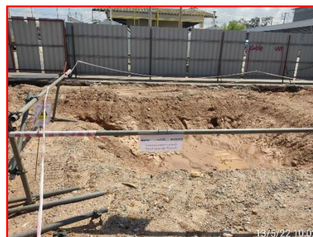
ภาพที่ 2.2-21 บ่อพักน้ำฝน
