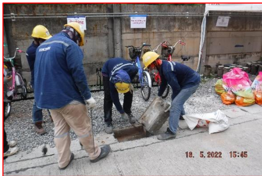
ภาพที่ 2.2-36 การขุดลอกรางระบายน้ำ
