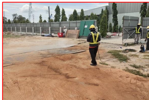
บริเวณพื้นที่ก่อสร้างหน่วยปรับปรุงคุณภาพน้ำมันดีเซล ภาพที่ 2.2-1 การฉีดพรมน้ำบริเวณพื้นที่ก่อสร้าง
