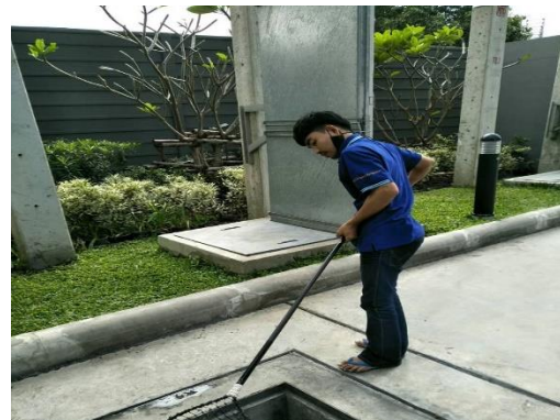
ทำความสะอาดบ่อพักน้ำ
