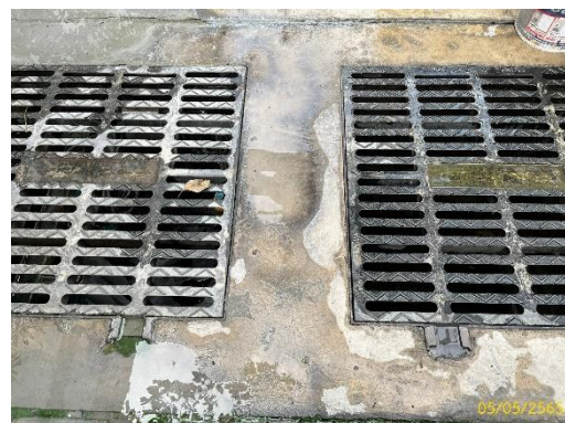
บ่อพักน้ำพร้อมตะแกรงดักขยะ
