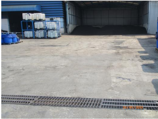
รูปที่ 18 รังดักตะกอนแนวเข้า-ออก อาคารเก็บถ่านหิน
