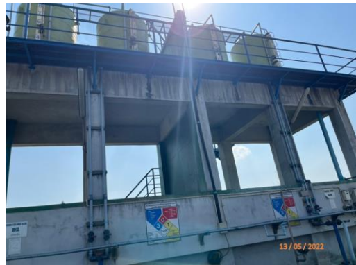
รูปที่ 36 คั่นคอนกรีตบริเวณถังกรด-ด่าง
