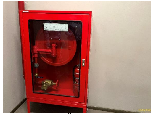
ตู้สายฉีดน้ำดับเพลิง FHC
