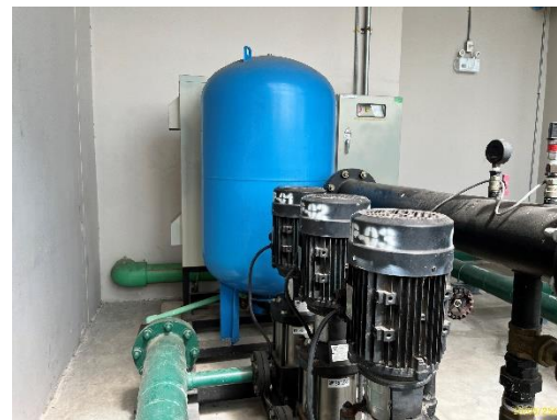
Booster Pump ชั้นดาดฟ้า
