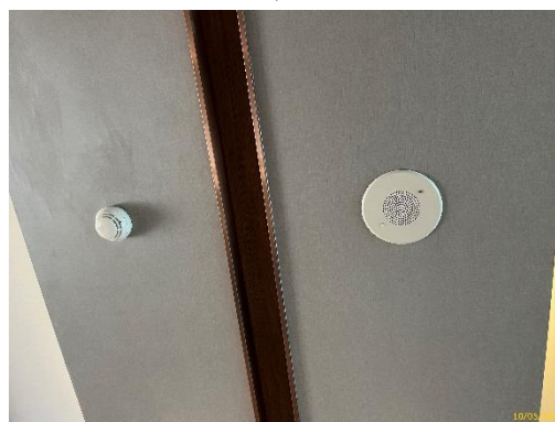
เครื่องจับควันและลำโพงแจ้งเหตุเพลิงไหม้
