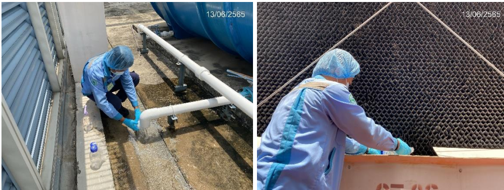
ภาพที่ 3.5.4-1 การเก็บตัวอย่างน้ำบริเวณที่เข้าและออกห่อฝึ้งเย็น
