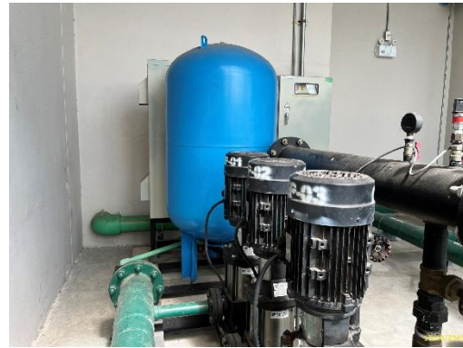
Booster Pump ชั้นดาดฟ้า
