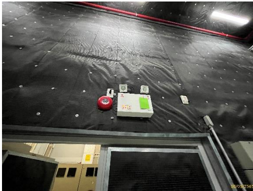
ไฟฉุกเฉินห้องกำเนิดไฟฟ้า
