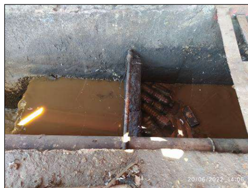
รูปที่ 8 บ่อแยกน้ำ-น้ำมัน
