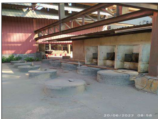
รูปที่ 9 ระบบบำบัดน้ำเสียสำเร็จรูปชนิดเกรอะ-กรองไร้อากาศ
