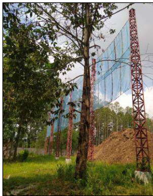
รูปที่ 3 การปลูกต้นไม้ทรงสูงและติดตั้งผ้าใบด้านเหนือลมป้องกันการฟุ้งกระจายของฝุ่น
