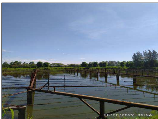
รูปที่ 7 บ่อพักน้ำหล่อเย็น (spray pond)
