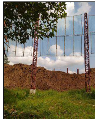
รูปที่ 3 การปลูกต้นไม้ทรงสูงและติดตั้งผ้าใบด้านเหนือลมป้องกันการฟุ้งกระจายของฝุ่น
