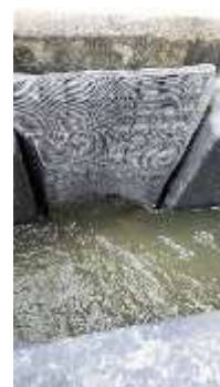
ภาพที่ 2.2-15 จุดดักตะกอนก่อนระบายน้ำออกนอกพื้นที่โครงการ
