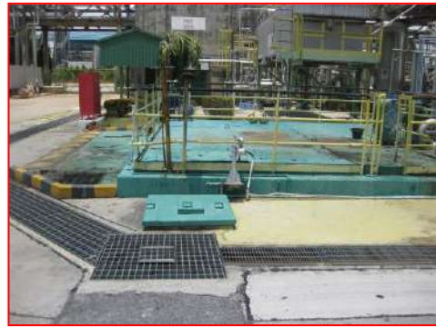
ภาพที่ 2.2-13 บ่อรับน้ำปนเปื้อนน้ำมัน
