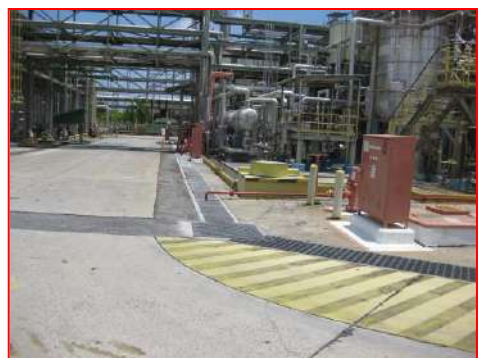
ภาพที่ 2.2-11 รางระบายน้ำฝนปนเปื้อนน้ำมัน
