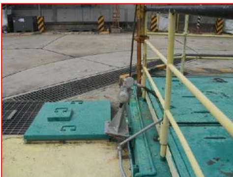
ภาพที่ 2.2-14 ฝาปิดบ่อรับน้ำฝนปนเปื้อนน้ำมัน
