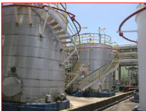
ภาพที่ 2.2-35 Dike กันรอบถังเก็บสารเคมี
