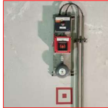
ภาพที่ 2.2-38 Fire Alarm แจ้งเหตุฉุกเฉิน
