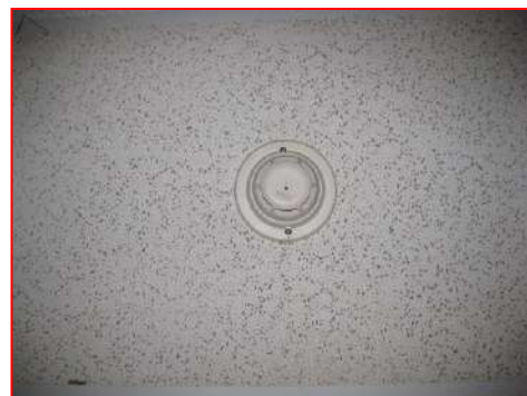
ภาพที่ 2.2-34 Smoke and Heat Detector
