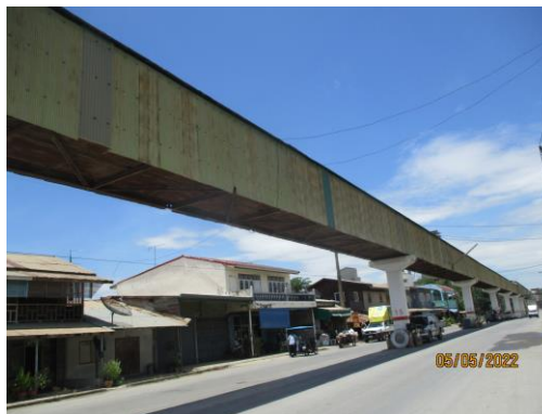
รูปที่ 5 สายพานลำเลียงที่ผ่านชุมชนมีฝาทรงปิดมิดชิด
