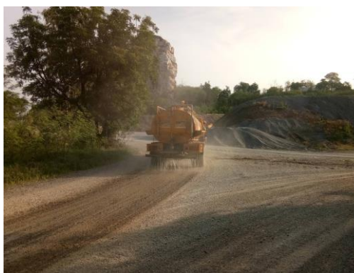
รูปที่ 6 การฉีดพรมน้ำเส้นทางขนแร่
