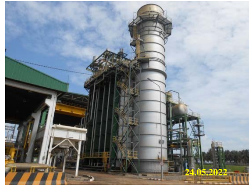
รูปที่ 2 ปล่อง HRSG 21
