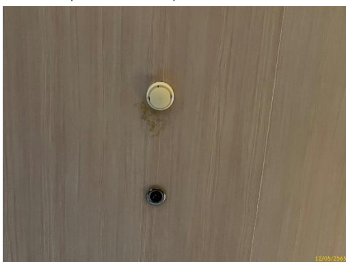
หัวกระจายน้ำดับและเครื่องตรวจจับควัน
