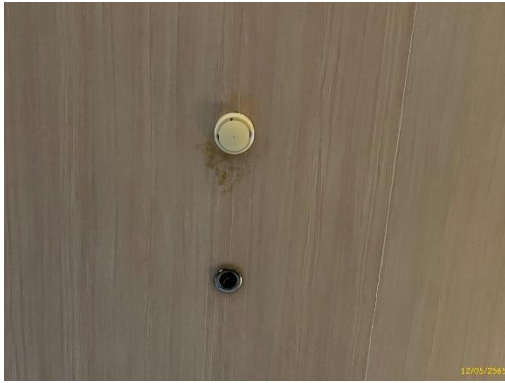
หัวกระจายน้ำดับเพลิงและเครื่องตรวจจับควัน
