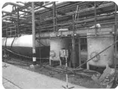
รูปตัวอย่างอุปกรณ์เก็บกัก Liquid waste และหน่วยบำบัด VOCs ที่ไม่เหมาะสม
