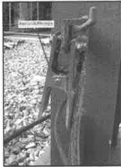
การต่อสายดิน สำหรับ Mobile Generator
