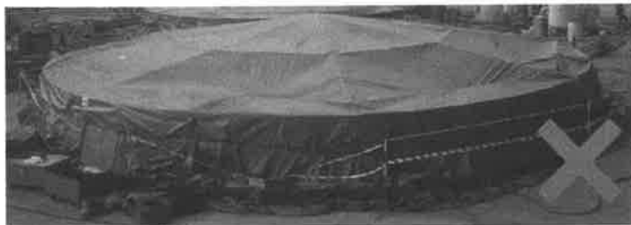
รูปตัวอย่างอุปกรณ์เก็บกัก Liquid waste และหน่วยบำบัด VOCs ที่ไม่เหมาะสม
