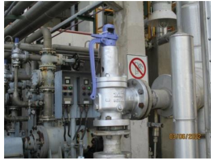
รูปที่ 61 Safety Valve (Relief & Vacuum Valve และ Shutoff Valve)
