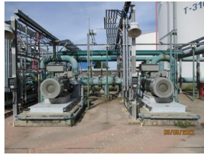
รูปที่ 59 Electric Jockey Pump
