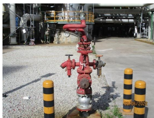
รูปที่ 47 Water Hydrants with Monitors
