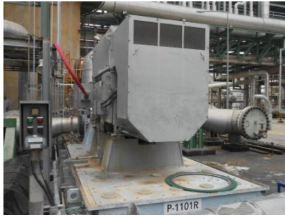
รูปที่ 58 Electric Fire Pump
