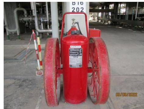
รูปที่ 50 Wheeled Fire Extinguisher
