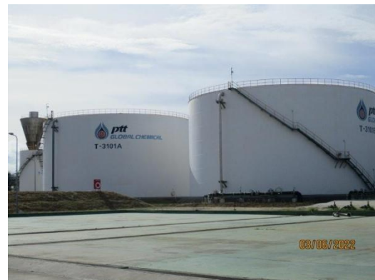
รูปที่ 57 Fire Water Tank (15,000 m 3 )
