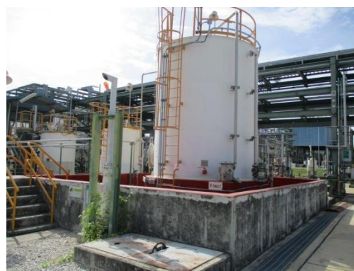
รูปที่ 42 ถังคอนกรีตล้อมรอบถังเก็บสารเคมี
