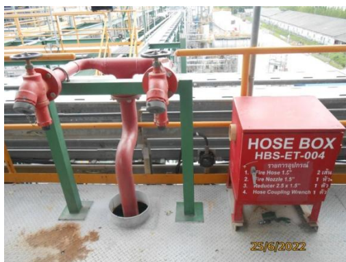
รูปที่ 51 Water Hydrants (Indoor & Outdoor)
