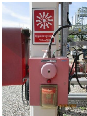
รูปที่ 54 Manual Fire Alarm
