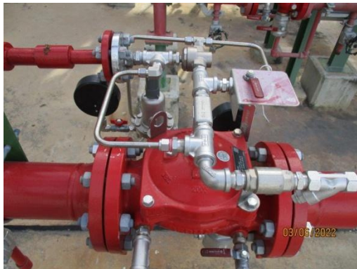
รูปที่ 48 Deluge Valve System
