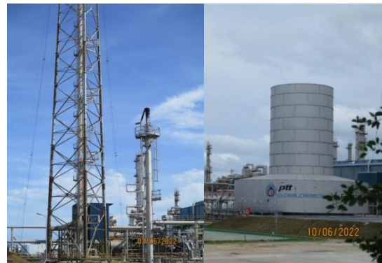
รูปที่ 4 หอเผาความดันต่ำ หอเผาความดันสูง และหอผาชนิด EGF
