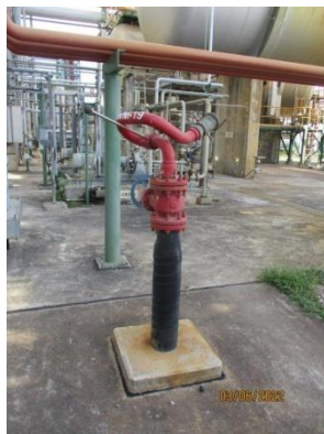
รูปที่ 49 Water Fix Monitor
