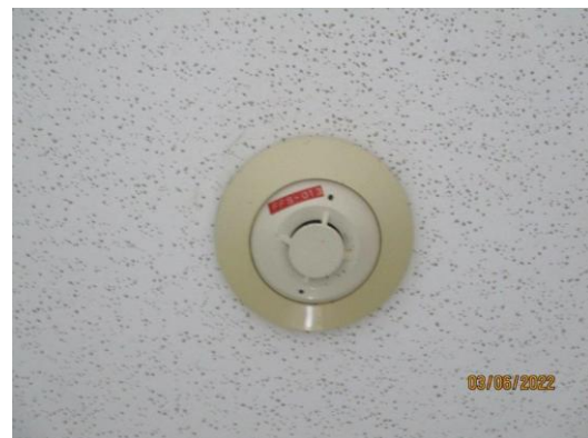
รูปที่ 55 Smoke Detector
