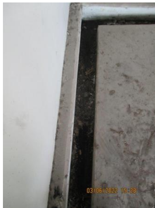
รูปที่ 27 รางระบายรวบรวมน้ำเสีย ภายในอาคารเก็บกากของเสีย
