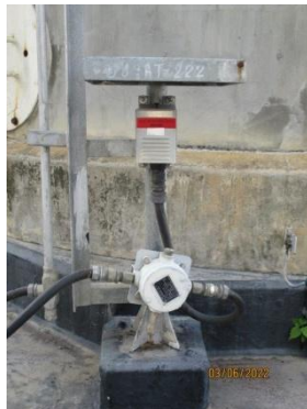
รูปที่ 43 Fixed Gas Detector
