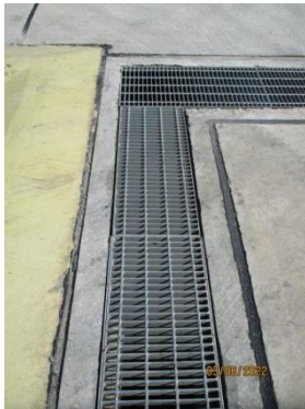
รูปที่ 13 รางระบายน้ำฝนภายในโรงงาน
