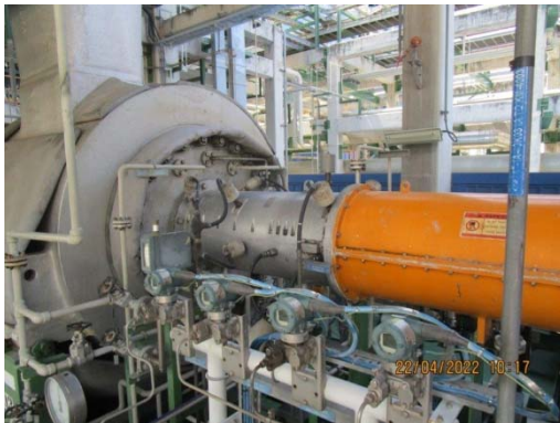
รูปที่ 61 ระบบตรวจสอบการสั่น ของคอมเพรสเซอร์
