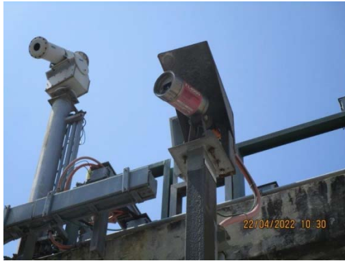
รูปที่ 47 Heat Detector
