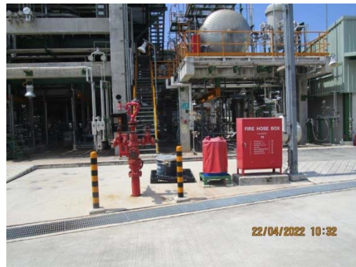
รูปที่ 42 Hydrant และ Hose box
