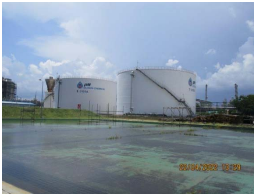
รูปที่ 49 ถังสำรองน้ำดับเพลิง
