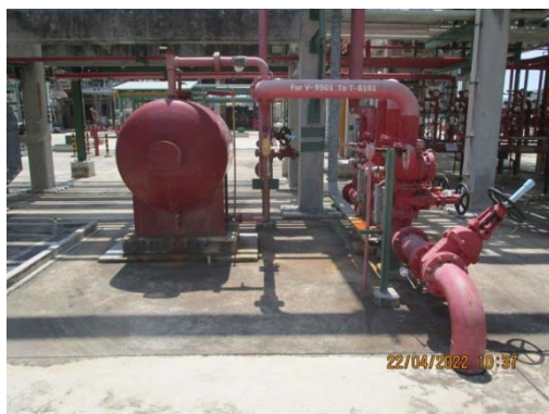
รูปที่ 43 ระบบโฟม (Foam System)
