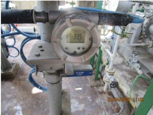
รูปที่ 55 ระบบวัดอุณหภูมิ บริเวณถังเกิดปฏิกิริยา
