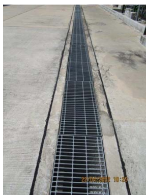
รูปที่ 75 รางระบายน้ำที่มีตะแกรงปิดสำหรับรองรับ น้ำที่ใช้ทำความสะอาดพื้นที่อาคารเก็บวัสดุ
