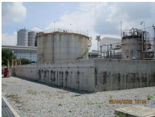
รูปที่ 33 คันคอนกรีตรอบถังเก็บสารเคมี
