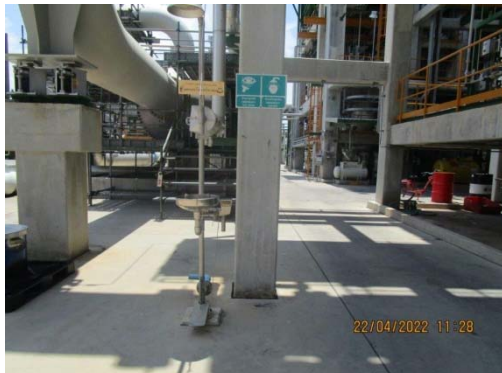
รูปที่ 37 อ่างล้างตาและร่างกายฉุกเฉิน
