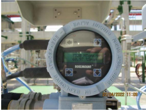
รูปที่ 59 อุปกรณ์วัดอัตราการไหลของสารในท่อ
