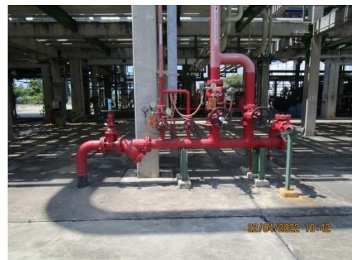
รูปที่ 40 ระบบน้ำดับเพลิง (Deluge System)
