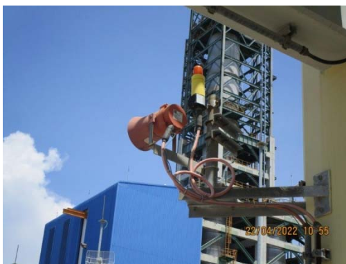
รูปที่ 51 ระบบกระจายเสียงในพื้นที่โรงงาน
