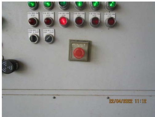
รูปที่ 65 ระบบ Emergency Shutdown System
