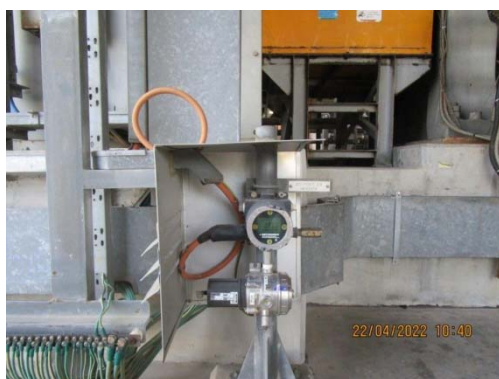
รูปที่ 45 Gas Detector
