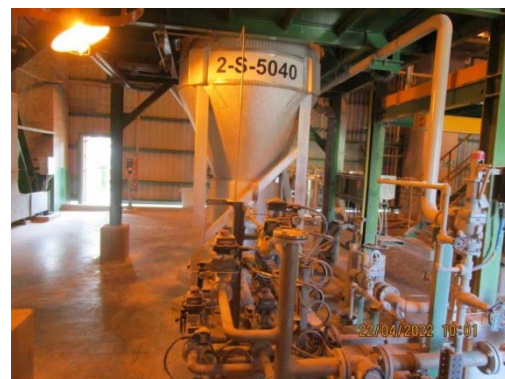
รูปที่ 6 การติดตั้งอุปกรณ์การขนส่งเม็ดพลาสติก โดยใช้น้ำ (Hydraulic Conveying)
