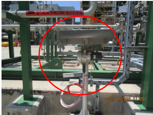
รูปที่ 35 Gas Detector บริเวณถังเก็บสารเคมี และสารไวไฟ
