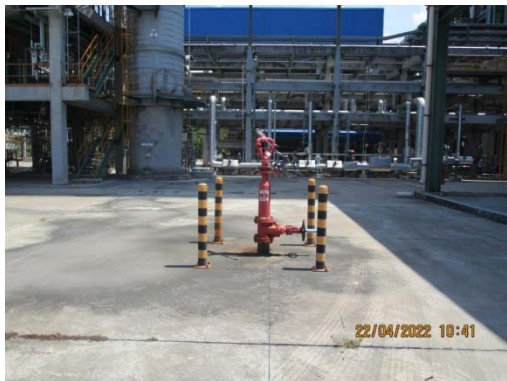
รูปที่ 41 หัวฉีดน้ำดับเพลิง
