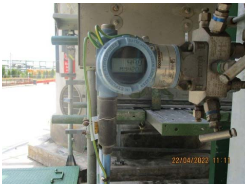
รูปที่ 63 อุปกรณ์วัดระดับของสารเคมีในถังเก็บ
