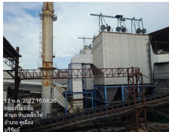
รูปที่ 4 ระบบบำบัดมลพิษทางอากาศ
