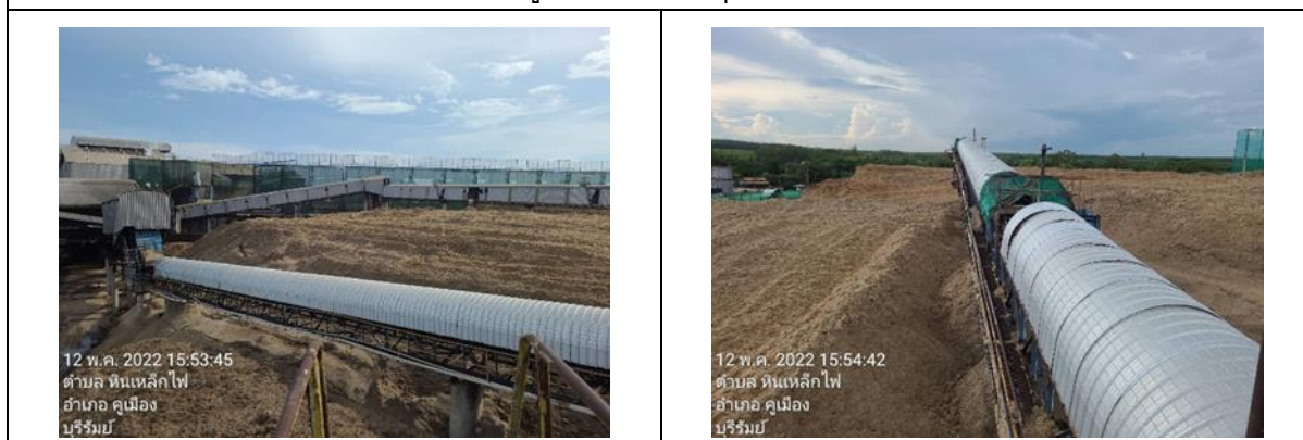
รูปที่ 8 ระบบสายพานลำเลียงเชื้อเพลิงแบบปิด
