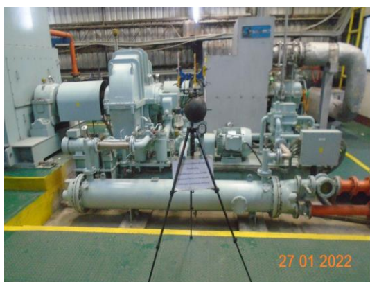
บริเวณเครื่องกำเนิดไฟฟ้าแบบกังหันไอน้ำขนาด 4 เมกะวัตต์
