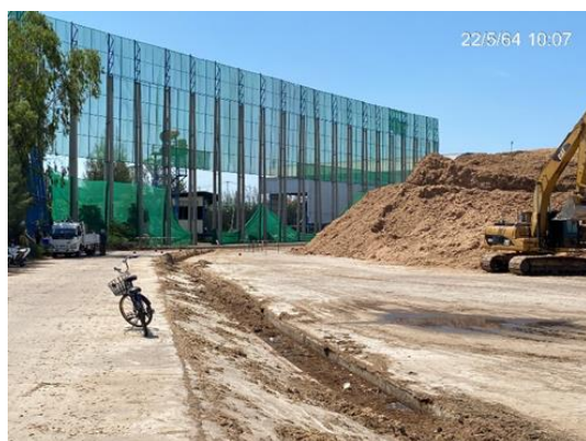
รูปที่ 18 รางระบายน้ำรอบลานกองเก็บเชื้อเพลิง
