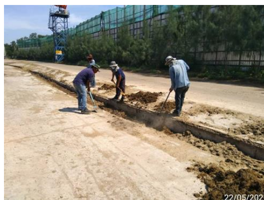
รูปที่ 18 รางระบายน้ำรอบลานกองเก็บเชื้อเพลิง
