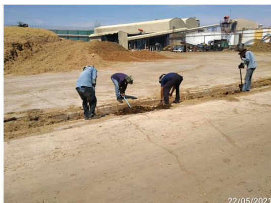
รูปที่ 18 รางระบายน้ำรอบลานกองเก็บเชื้อเพลิง
