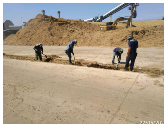
รูปที่ 18 รางระบายน้ำรอบลานกองเก็บเชื้อเพลิง
