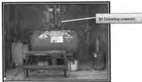
รูปที่ 6: แสดง Unloading Station ของ Triethyl Aluminium (16.209B)
