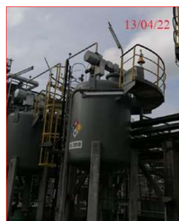
ภาพที่ 2.2-39 ถังตัวเร่งปฏิกิริยา หรือตัวกระตุ้นเร่งปฏิกิริยาในระบบปิด
