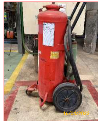
ถังดับเพลิงมือถือชนิดเคมีแห้ง ชนิดเคลื่อนด้วยล้อ ชนิด ABC ขนาด 50 กิโลกรัม
