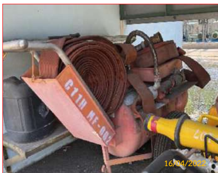
ถังดับเพลิงชนิดน้ำยาโฟมขนาด 120 ลิตร
