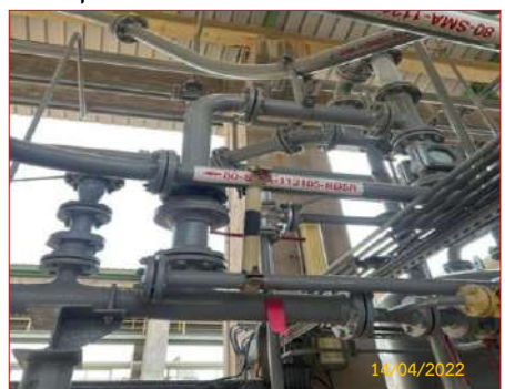
ภาพที่ 2.2-45 อุปกรณ์ระบายความดัน Pressure Relief Valve
