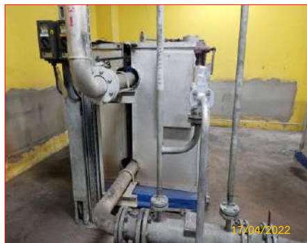
ภาพที่ 2.2-21 Acoustic Hood ที่บริเวณ Hexane Separation & Dring และอาคาร Blower Station
