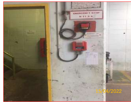
ภาพที่ 2.2-47 ระบบหยุดแบบฉุกเฉิน (Emergency Shutdown)
