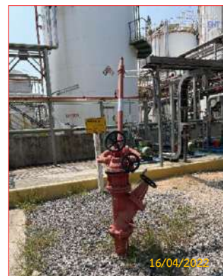
ปืนฉีดน้ำดับเพลิงชนิดติดตั้งประจำที่
