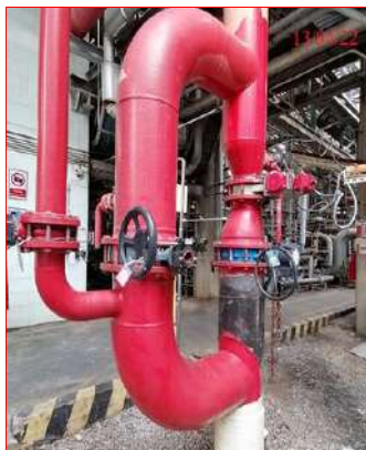
ภาพที่ 2.2-58 ระบบ Deluge System บริเวณถังเก็บกัก
