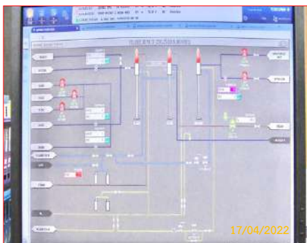
ภาพที่ 2.2-7 แผงควบคุมบริเวณหน้างาน (Local Panel)
