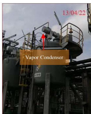
ภาพที่ 2.2-52 ระบบ Vapor Condenser ถังเก็บกักตัวเร่งปฏิกิริยา
