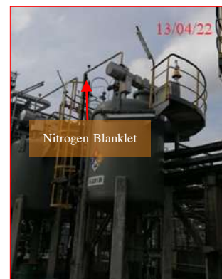
ภาพที่ 2.2-51 ระบบ Nitrogen Blanket
