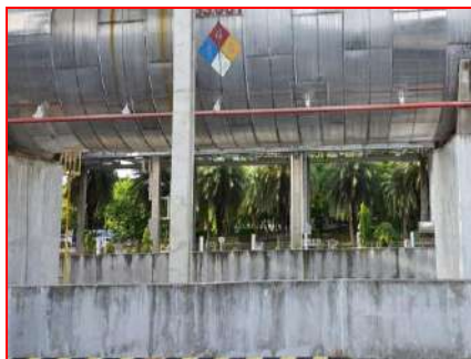
ภาพที่ 2.2-50 คั่นคอนกรีต รอบถังเก็บบิวเทน-1, ถังเก็บก๊าซปิโตรเลียมเหลว
