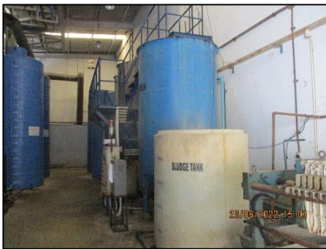
รูปที่ 2-8 ระบบบำบัดน้ำเสียทางเคมี
