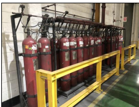
รูปที่ 2-41 ระบบ CO 2 ดับเพลิงอัตโนมัติ
