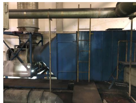
รูปที่ 2-6 Activated Carbon Filter
