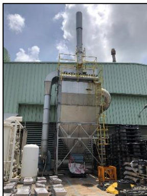
รูปที่ 2-3 Dust Collector
