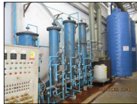
รูปที่ 2-8 ระบบบำบัดน้ำเสียทางเคมี
