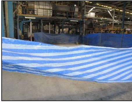
รูปที่ 2-2 การชิงตาข่ายกันบริเวณรอการติดตั้งเครื่องจักร
