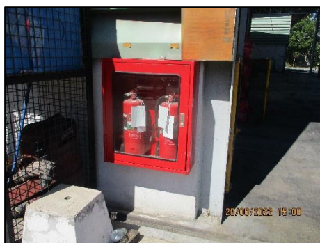
รูปที่ 2-39 ถังดับเพลิง ตู้เก็บอุปกรณ์ดับเพลิง และตู้เก็บอุปกรณ์ฉุกเฉิน
