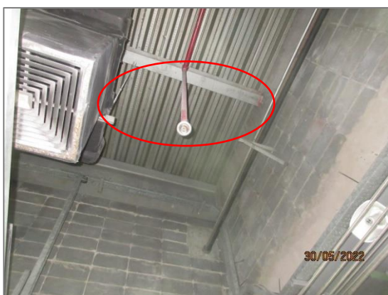
ภาพถ่ายที่ 2.2-55 ระบบน้ำดับเพลิงแบบ Automatic Wet Pipe Sprinkler ที่หน่วยผลิต Compounding
