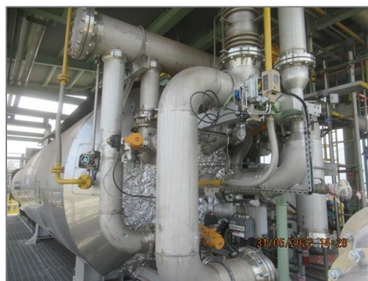
ภาพถ่ายที่ 2.2-65 ระบบ Thermal Oxidizer (TO)
