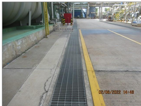
ภาพถ่ายที่ 2.2-15 รางระบายน้ำภายในโครงการ ส่วนผลิต PC
