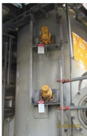
ภาพถ่ายที่ 2.2-7 ระบบ Interlock สำหรับหยุดการป้อนไค้ก
