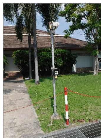
ภาพถ่ายที่ 2.2-57 เครื่องตรวจจับ CO แบบต่อเนื่อง (CO Concentration Online) ในส่วนผลิต CO
