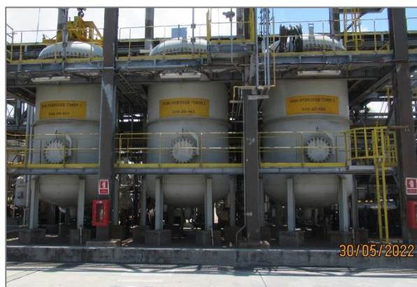
ภาพถ่ายที่ 2.2-8 หอเหล็กไฮดรอกไซด์ สำหรับกำจัดซัลเฟอร์
