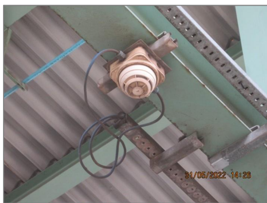
ภาพถ่ายที่ 2.2-66 เครื่องตรวจจับก๊าซไวไฟ (Flammable Gas Detector)
