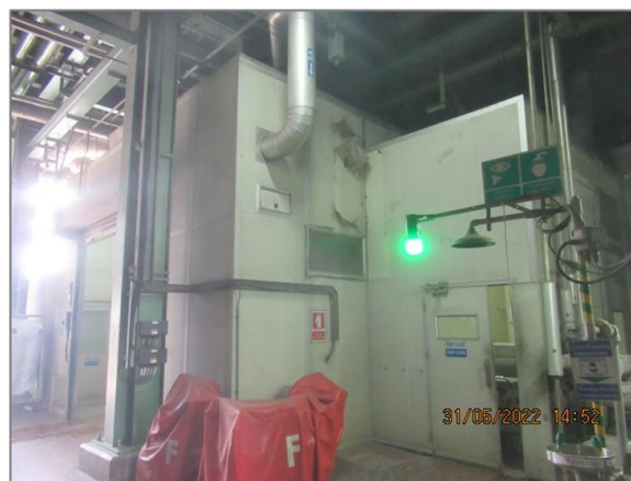
ภาพถ่ายที่ 2.2-39 ฝักบัวและที่ล้างตาฉุกเฉิน ในพื้นที่ที่เกี่ยวข้องกับสารเคมี
