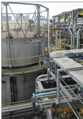
ภาพถ่ายที่ 2.2-44 อุปกรณ์วัดระดับแบบวัดเฉพาะ จุดแบบ Local Scale
