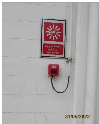
ภาพถ่ายที่ 2.2-58 ปุ่มแจ้งสัญญาณไฟไหม้ (Fire Alarm Button) ในส่วนผลิต CO
