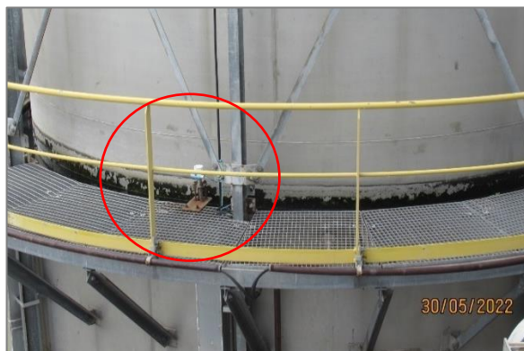
ภาพถ่ายที่ 2.2-45 อุปกรณ์วัดระดับแบบวัดค่าต่อเนื่อง
