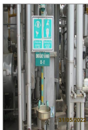
ภาพถ่ายที่ 2.2-41 ฝักบัวฉุกเฉิน และอ่างล้างตาฉุกเฉิน ส่วนผลิต CO
