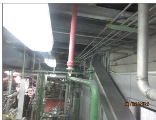
ภาพถ่ายที่ 2.2-55 ระบบน้ำดับเพลิงแบบ Automatic Wet Pipe Sprinkler ที่หน่วยผลิต Compounding
