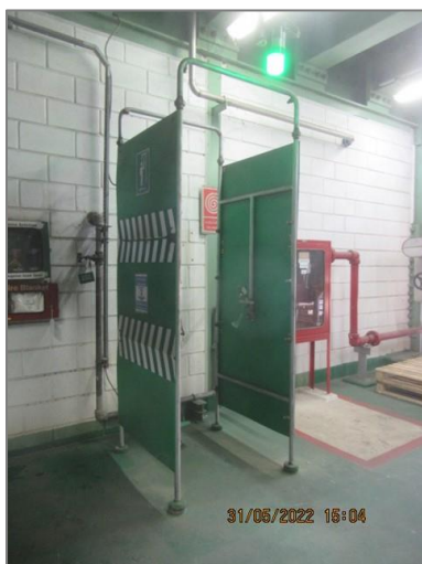
ภาพถ่ายที่ 2.2-39 ฝักบัวและที่ล้างตาฉุกเฉิน ในพื้นที่ที่เกี่ยวข้องกับสารเคมี
