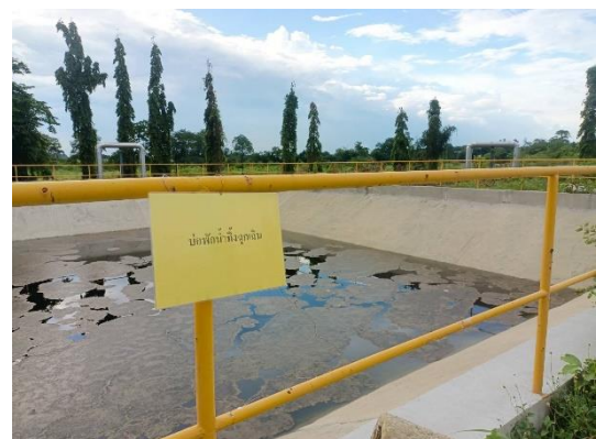
รูปที่ 33 บ่อพักน้ำทิ้งฉุกเฉิน
