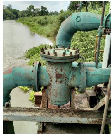
รูปที่ 34 ตะแกรงบริเวณสถานีสูบน้ำ (ตะแกรงอยู่ปลายท่อสูบน้ำ)
