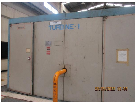
รูปที่ 21 ปิดครอบเครื่องจักรที่มีเสียงดัง
