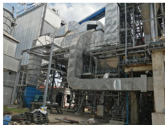
รูปที่ 44 ติดตั้งฉนวนกันความร้อน
