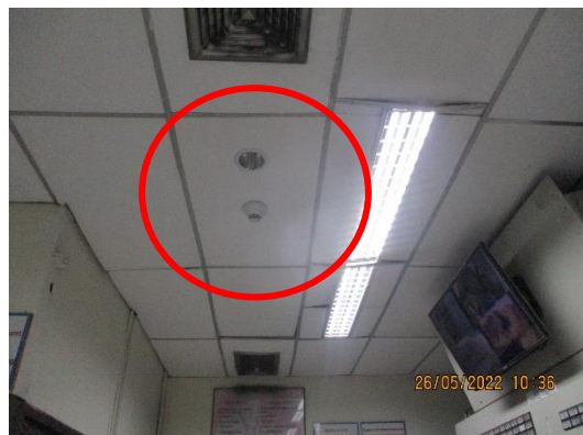
รูปที่ 52 อุปกรณ์ตรวจจับควัน
