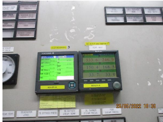
รูปที่ 13 ระบบการแจ้งเตือนกรณี ESP ทำงานขัดข้อง
