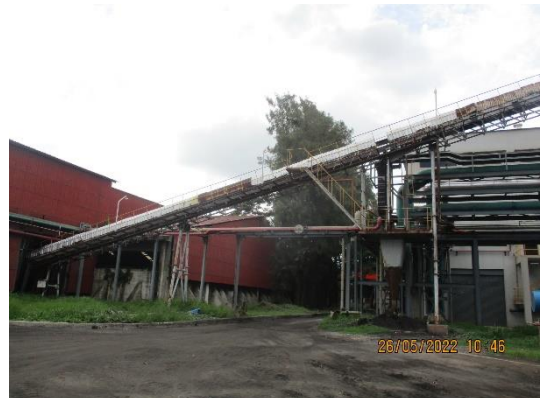
รูปที่ 6 สายพานลำเลียงเชื้อเพลิงแบบปิด
