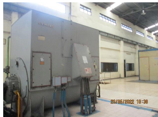
รูปที่ 21 ปิดครอบเครื่องจักรที่มีเสียงดัง
