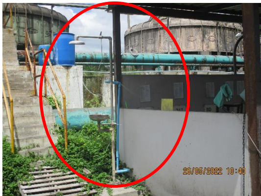
รูปที่ 46 อ่างล้างตาและฝักบัวอาบน้ำ
