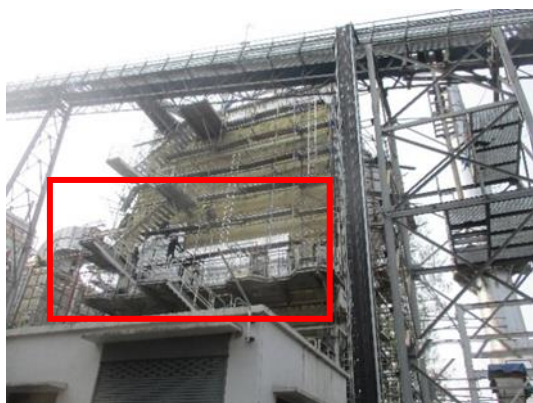
รูปที่ 44 ติดตั้งฉนวนกันความร้อน
