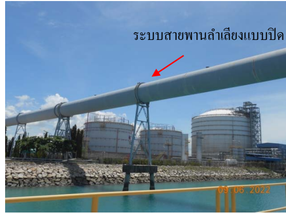
รูปที่ 2 การขนถ่ายถ่านหิน ภายในระบบสายพานลำเลียงแบบปิด
