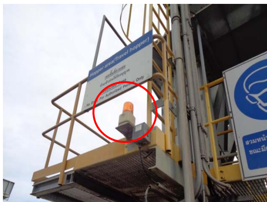
รูปที่ 11 ระบบไฟสัญญาณ
